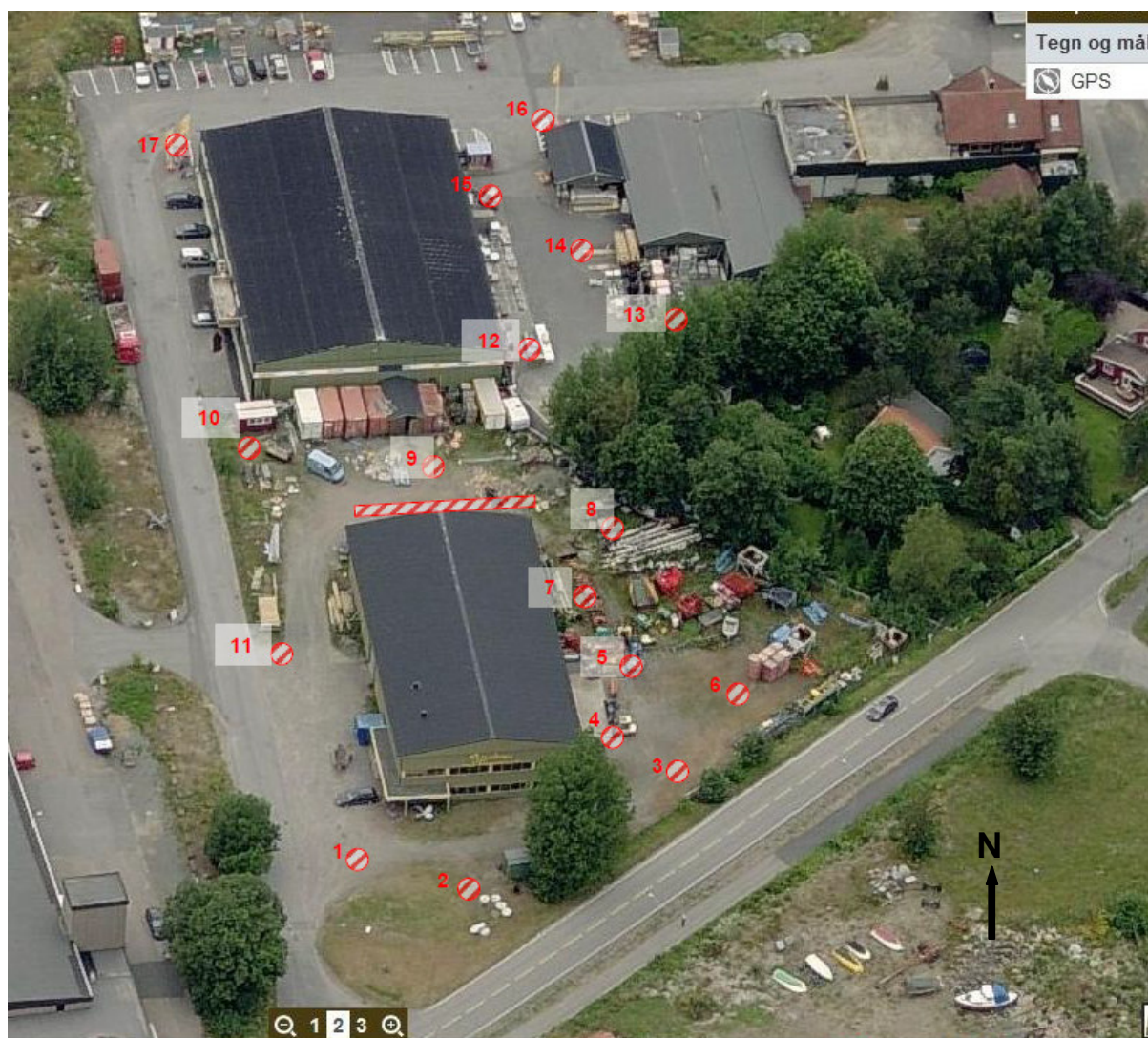
Figur 11 Område 3b – prøvepunkter er markert med rød ring. Bjerknes-bygget i sør og Byggmakker i nord.
