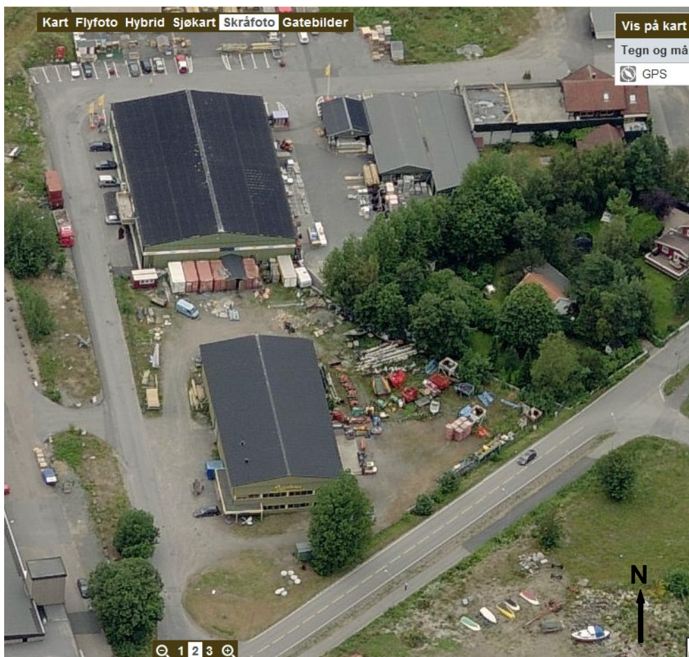
Figur 8 Område 3a – Byggmakker på nordlige del og tidligere Bjerknes-bygget i sør
