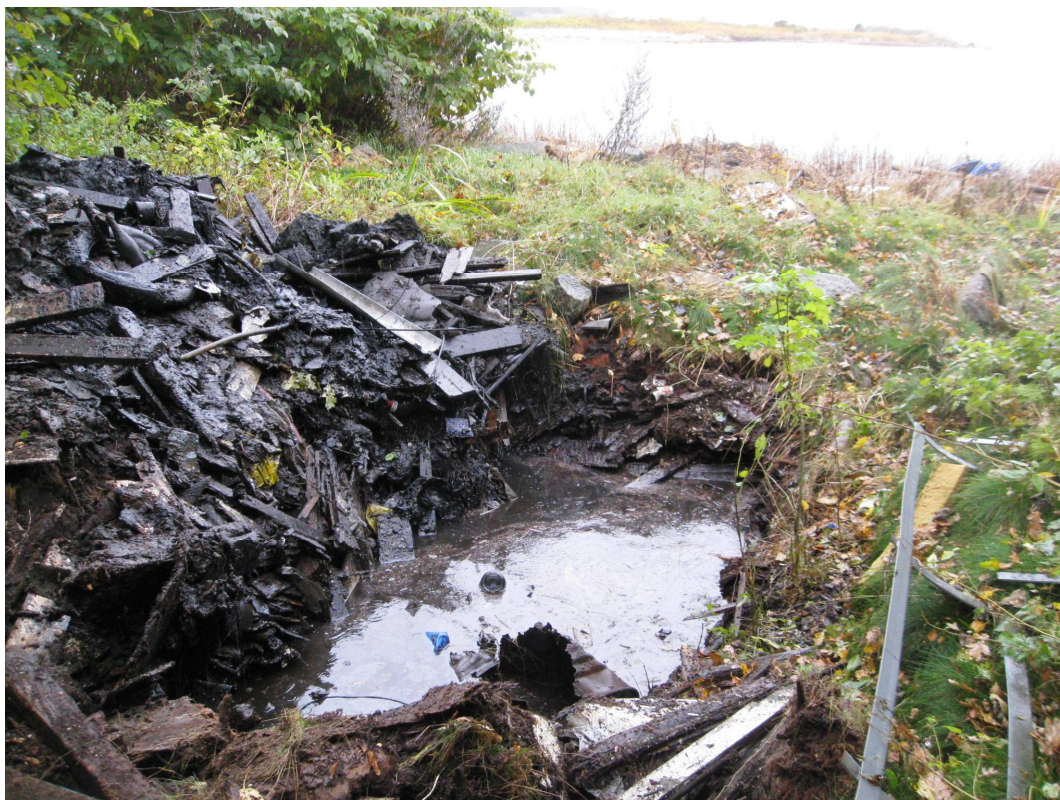
Figur 13 Område 1 – sjakt 8, fylling rett under overflaten ca 15 – 20 meter fra sjø
