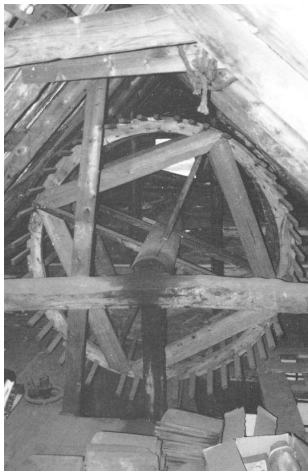
Gammelt vindehjul i Nedre Holmegate 20 (De røde sjøhus). Foto: P.C.O.
