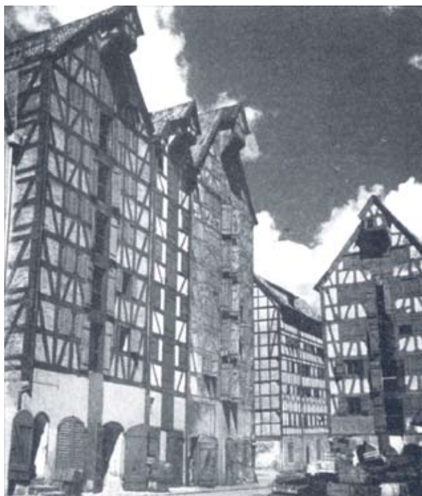
Sjøhus i utmurt bindingsverk i Kilingrad (tidl. Øst-Preusen) fra 17.-18. århundre. (Deutsche Fachwerkbauten, Herman Phleps.)
