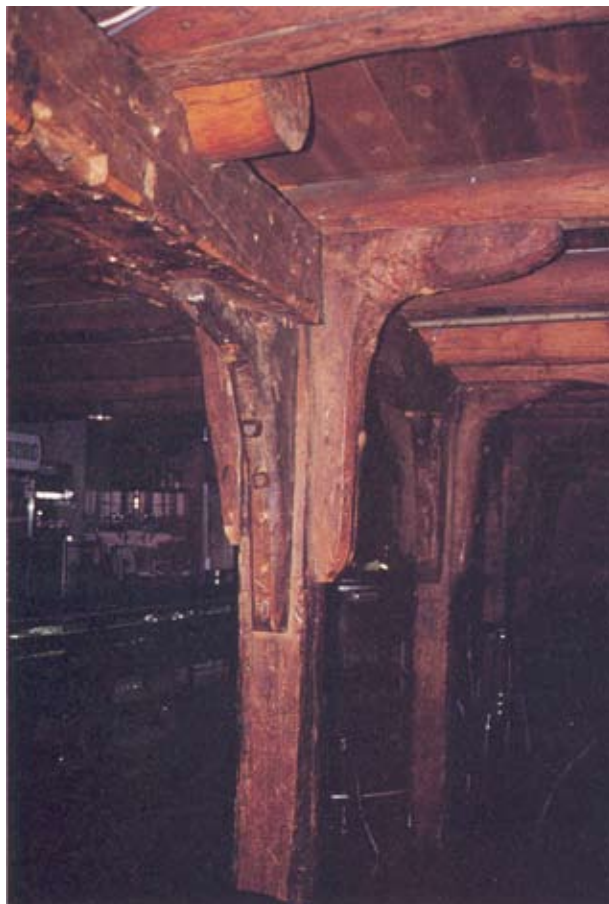
Detalj Nedre Holmegate 20 (Røde sjøhus). Karakteristisk bærekonstruksjon: avstiving med krumvokste knær. Foto: S.H.
