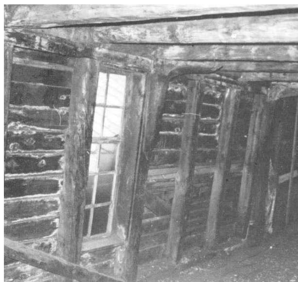
Bindingsverkvegg med trekledning, Østervåg 15. Foto S.H.
